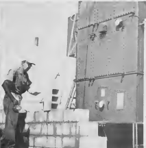
WELDING DI barra di reforzamento ariba un fire wall, ariba robes, y construction di e fire wall entre e transformernan ta un parti di e proyecto cu lo permiti Lago compra corriente for di gobiernu.
